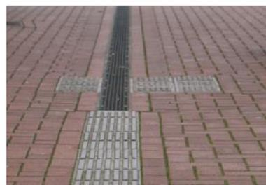
Abb. 36: Kombination taktiler Elemente mit der Entwässerung in der Markttwiete
