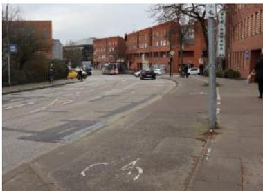
Abb. 161: Unebenheiten, Verwerfungen und Wechsel prägen die Oberflächen der Geh- und Radwege am nördlichen Eutiner Ring.
